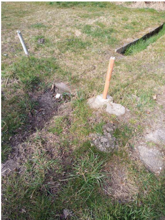
Abbildung 18: Ehemaliger Entwässerungsgraben (Foto: Hansestadt Stralsund)
